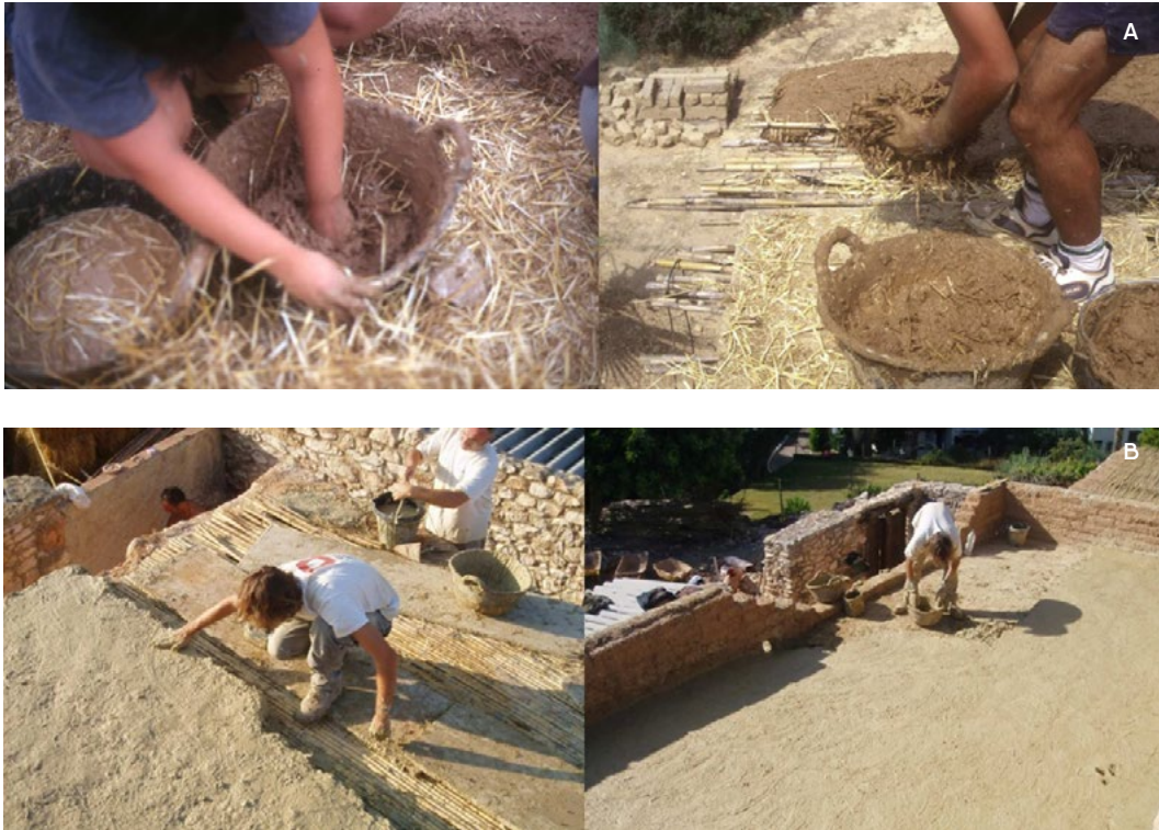
Figura 3. A. Barreja d'argila i palla; B. Col·locació de la barreja d'argila i palla sobre l'encanyissat
